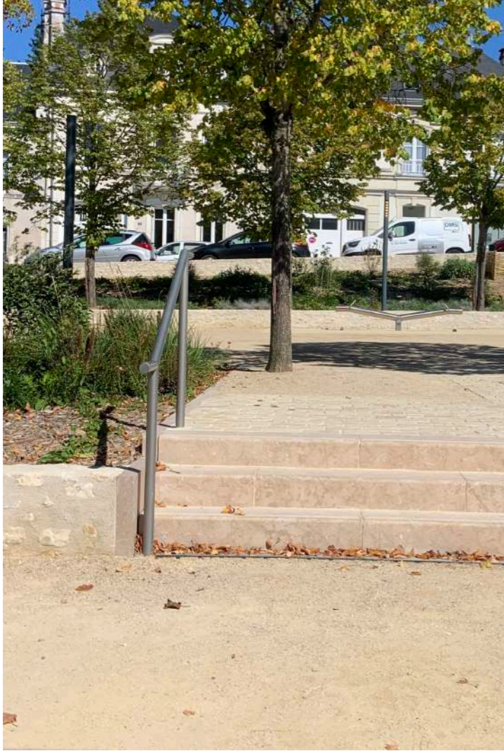
Escalier marches pierre calcaire (parvis mairie)
